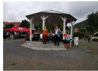
Neubau Pavillon im Kurpark Ilfeld
