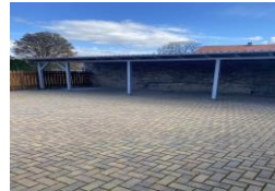
Überdachung auf der Hoffläche „Alte Schäferei“ Wolframshausen
