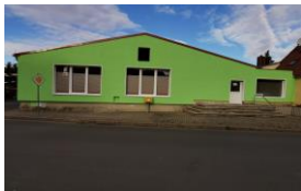
Fassadensanierung Vereinshaus Heimatverein 850 Jahre Bielen e.V.
